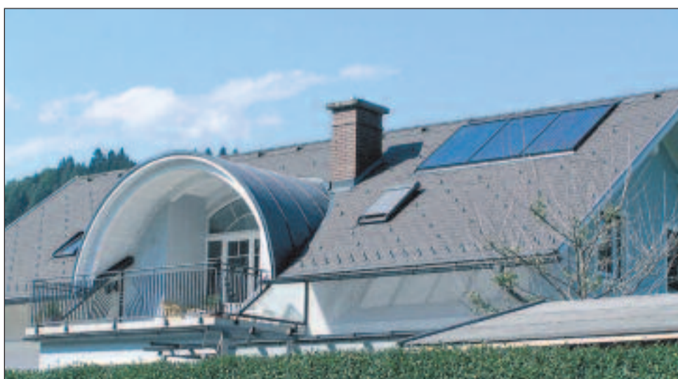
Le capteur Isisun s'intègre à fleur de couverture et se dissimule dans la toiture. Isisun d'Alliance chez Brossette. Tél. 04 72 72 05 05.
