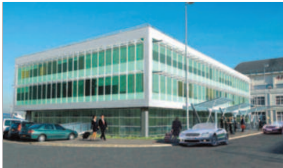
Une nouvelle aérogare de 3 200 m 2 sera opérationnelle en avril 2006.
