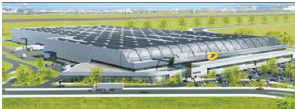
La plate-forme industrielle de la Poste sera capable de traiter 5 millions de plis par jour.
