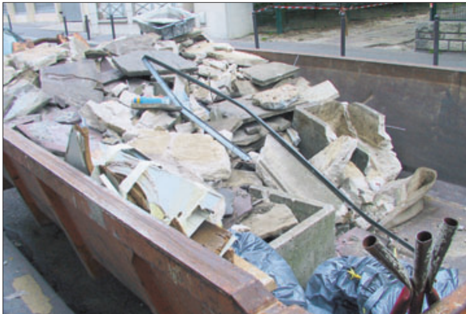
Gravats, solvants, peintures, acides, équipements électriques ou électroniques, tous les types de déchets sont enlevés puis traités via le site Dechets-chantier.ffbatiment.fr.
