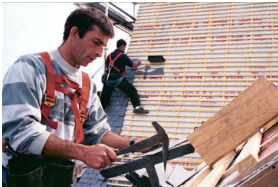
L'amélioration des conditions de travail et de sécurité constitue un enjeu important pour les métiers du bâtiment s'ils veulent attirer des jeunes à l'avenir. (Photo : FFB-Zoom Bâtiment)
