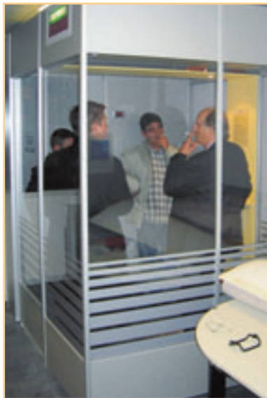
Extraction d'air mécanique, fermeture automatique des portes, superficie limitée, les espaces fumeurs doivent répondre à des normes très précises. (Photo : MSEI Environnement)
